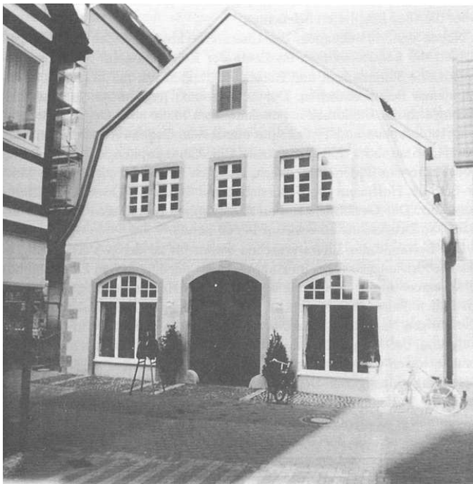
Grabbes Geburtshaus (Bruchstr. 27) nach Renovierung und Umbau
